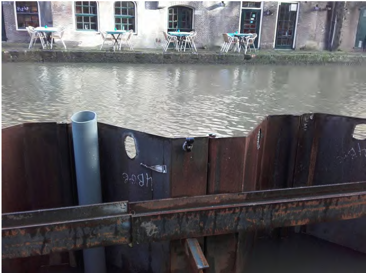
Figuur 1: prisma's op de damwand
